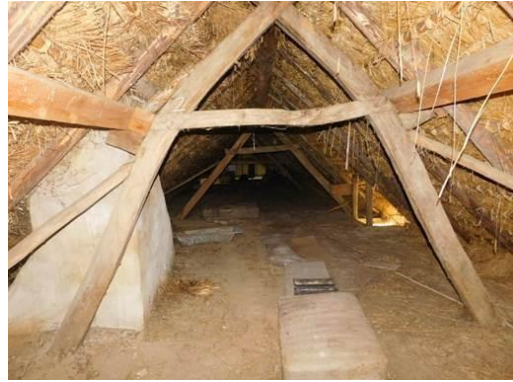
Tájház fedélszéke faanyagvédelmi felmérés során
